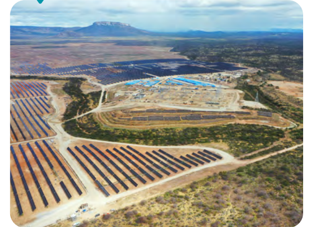
Parque Solar Futura I
