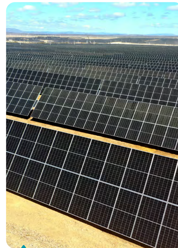
Parque Solar Futura I
